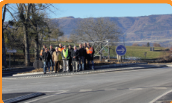
Réception des travaux du giratoire des Petits Pierres le 17 décembre
